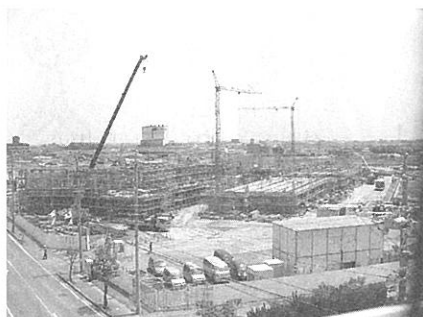
5/25 大型クレーン3機大活躍!
